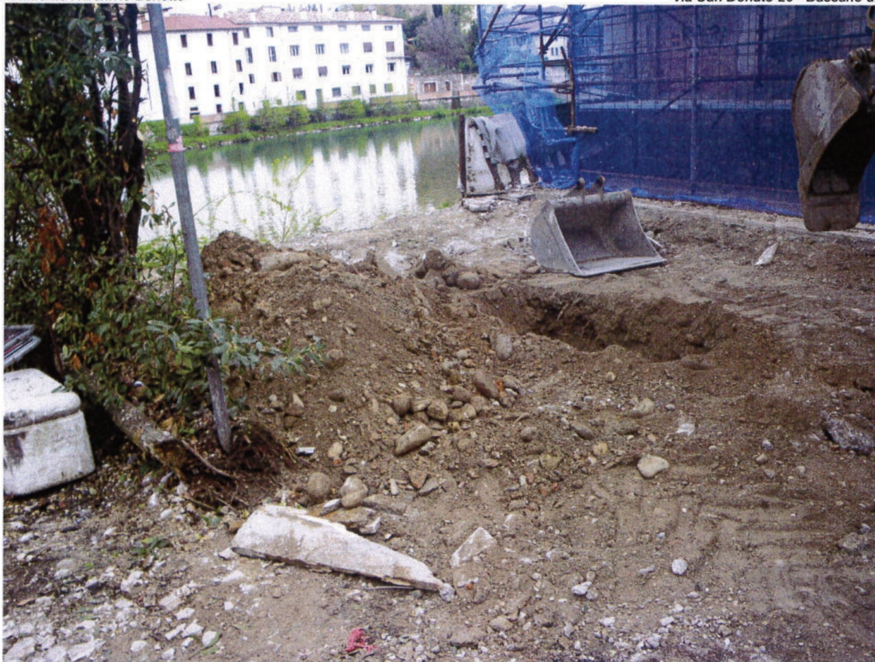
Foto N.1 : Esecuzione del Sondaggio spinto alla profondità di -2.8mt dal p.c. nell'area di posizionamento gru
