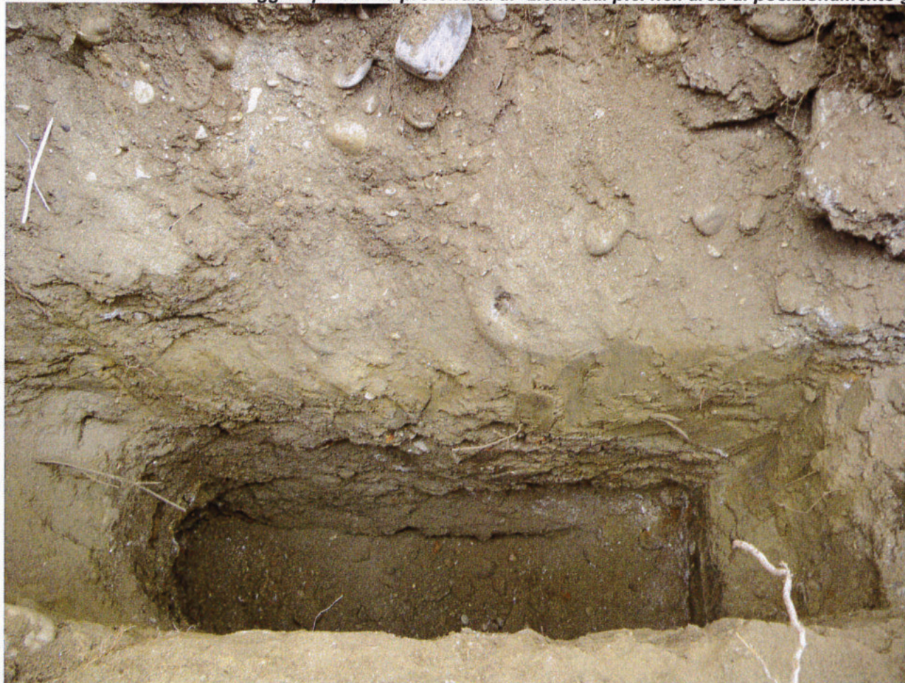
Foto n 2 : Sezione stratigrafia della trincea esplorativa spinta alla profondità di -2.8mt dal p.c.
